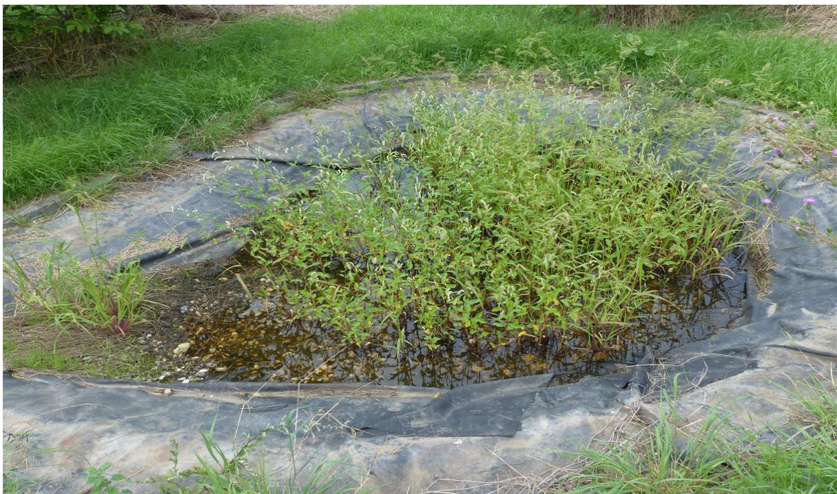
*Überraschenderweise hat sich in diesem Folientümpel auch etwas Regenwasser halten können. Die Folie ist an einigen Stellen defekt. Der Tümpel soll von Grund auf saniert werden (dann ein Beton-Tümpel).*
