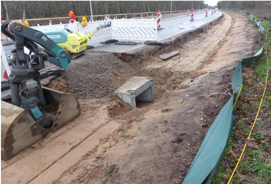
Das erste Tunnelement auf der Rückwanderungsseite ( 9.2.24)
