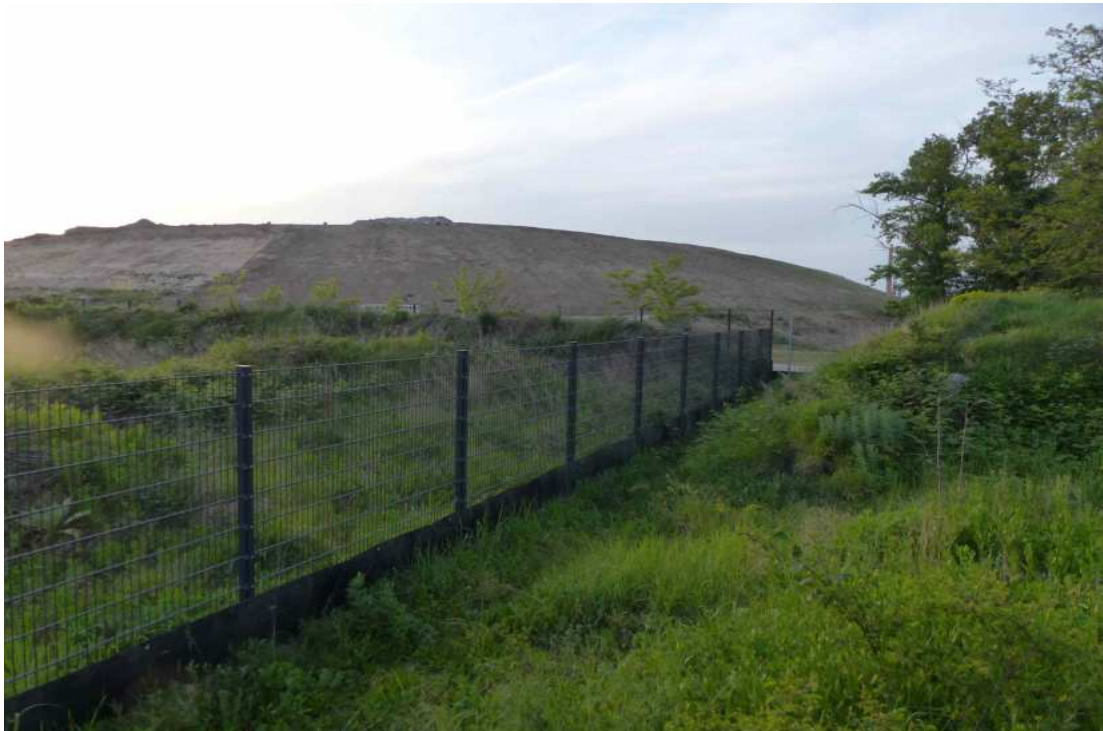
Im Hintergrund die neu modellierte Deponie-Böschung. Rechts ausserhalb des Bildes die Lagune
