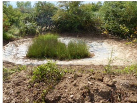
Die Folie ( links, im Februar mit reichlich Wasser) lag im linken Bereich tiefer. Außerdem wurde die Erde im Uferbereich kontinuierlich durch Regen eingeschwemmt. Auf dem rechten Foto ist der erhöhte Folien-Randbereich zu erkennen.
