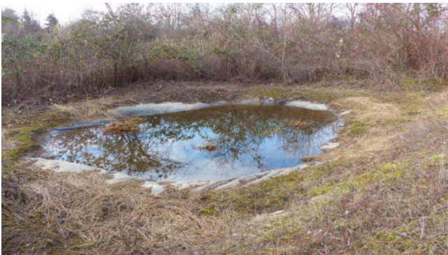
Die Folie ( links, im Februar mit reichlich Wasser) lag im linken Bereich tiefer. Außerdem wurde die Erde im Uferbereich kontinuierlich durch Regen eingeschwemmt. Auf dem rechten Foto ist der erhöhte Folien-Randbereich zu erkennen.
