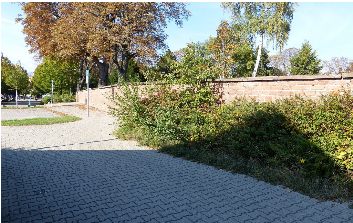
Friedhofsmauer Seckenheim, Südseite
